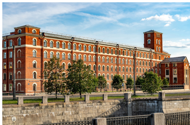
Наб. Обводного канала, д. 60
